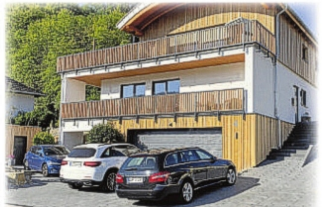
An großzügige Kfz-Stellplätze wurde auch gedacht.
